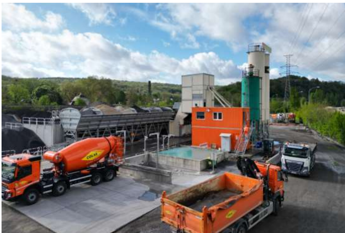
Figure 2: Centrale à béton de Colas Belgium à Seraing (Colas (2025))
